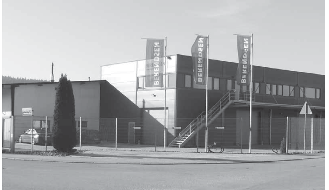
Die Firma Berendsen Textilservice lädt im Rahmen der Veranstaltungsreihe "Pfullendorfer Unternehmerwelten" zu einer Betriebsführung ein. Foto: Veranstalter
