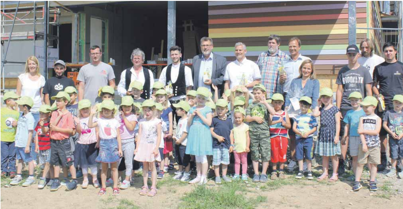
Große Freude herrschte bei den Vertretern der Stadt, bei den Handwerkern und vor allem bei den künftigen Bewohnern, den Kindern der Tagesstätte am Stadtgarten: Nach nur zehn Wochen Bauzeit wurde am vergangenen Montag Richtfest beim Familienzentrum Sonnenschein gefeiert. Der Einzug ist für Anfang 2019 geplant. Foto: Anthia Schmitt
